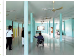
農場内にある障害者の職業自立のための研修宿泊施設(建設中)
